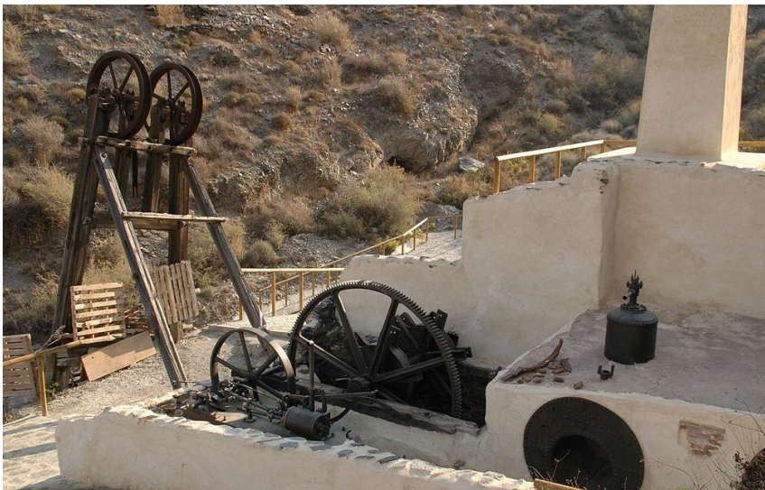
Máquina de vapor tras su restauración. Fuente: qhm.es
