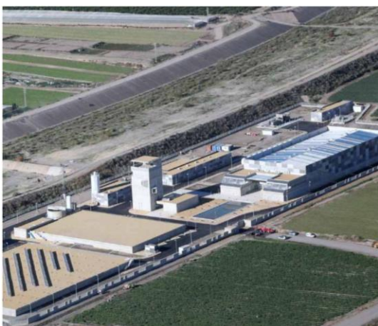
Desaladora del Bajo Almanzora (Fuente: http://www.acuamed.es/ )
