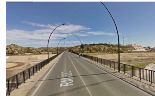
Puente RM-332 sobre el río Almanzora (Fuente: Google Maps)
