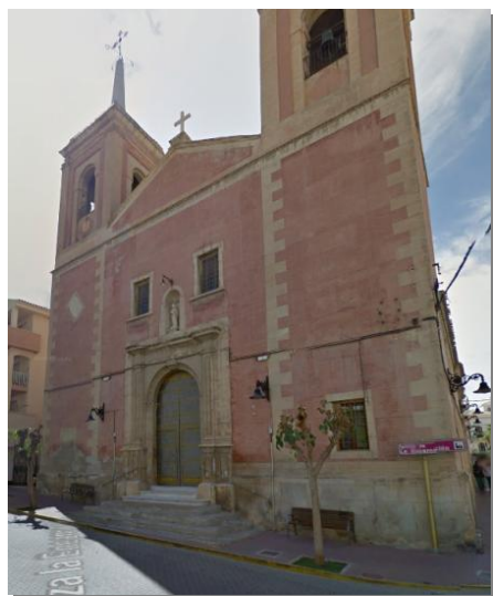
Fachada principal (Fuente: Google Maps)
